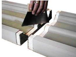
Verbindungsflächen mit Stoßarmierungs-Spachtelmasse oder Flex-Kleber vorspachteln.
